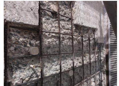
Figuur 1: Kathodische bescherming van gewapend beton d.m.v. opofferanodes
