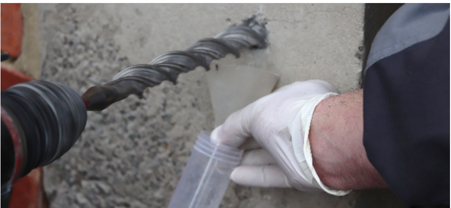
FIGUUR 17: HET ONTNEMEN VAN BOORSTOF VOOR DE BEPALING VAN HET CHLORIDEGEHALTE
