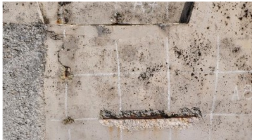
FIGUUR 11: VISUEEL WAARNEEMBARE AFWIJINGEN (SCHEUREN, VERKLEURINGEN, BLOOTLIGGENDE WAPENING, AFBROKKELINGEN)
