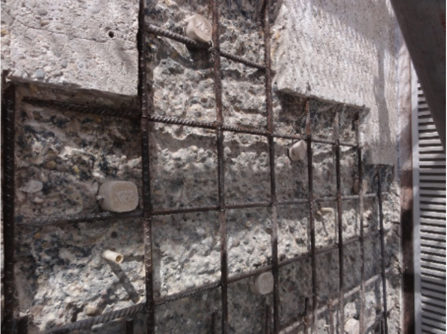
FIGUUR 22: KATHODISCHE BESCHERMING VAN GEWAPEND BETON D.M.V. OPOFFERANODES
