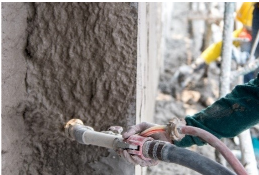
FIGUUR 21: HET AANBRENGEN VAN HERSTEMORTELM.B.V. DE NATTE SPUITMETHODE
