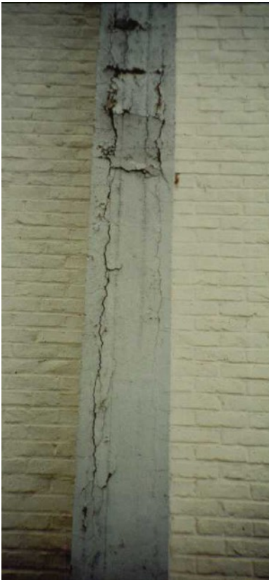
FIGUUR 11: VISUEEL WAARNEEMBARE AFWIJINGEN (SCHEUREN, VERKLEURINGEN, BLOOTLIGGENDE WAPENING, AFBROKKELINGEN)
