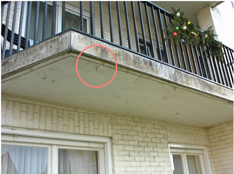
FIGUUR 4: STALACTIETVORMING ONDERAAN EEN BALKON
