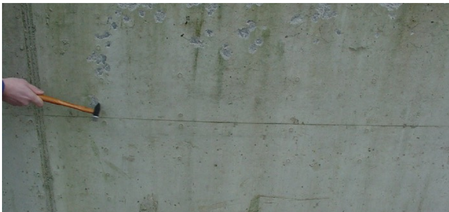
FIGUUR 12: OPZOEKEN VAN HOLKLINKE ZONES MET BEHULP VAN EEN METALEN HAMER
