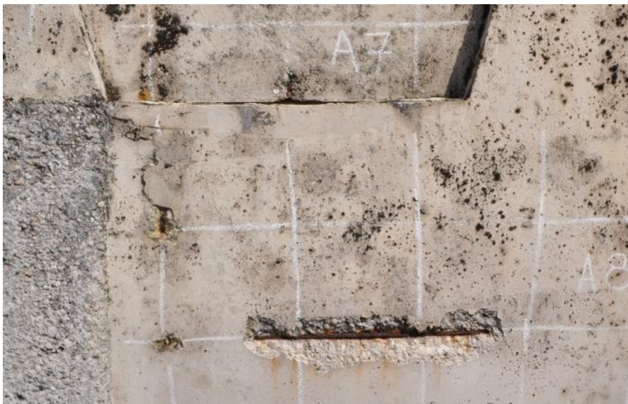
FIGUUR 13: BEPALING VAN DE LOCATIE VAN DE WAPENING MET EEN PACHOMETER
