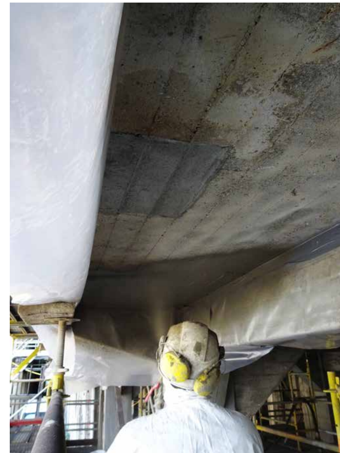
Aanbrengen van een carbonatatie-remmende coating na betonherstelling.
