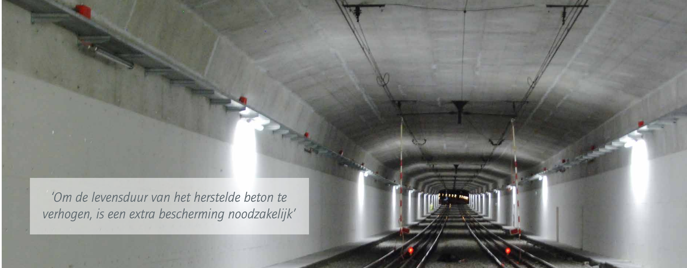
Plaatmaterialen voor passieve brandbescherming van beton in een spoortunnel.
