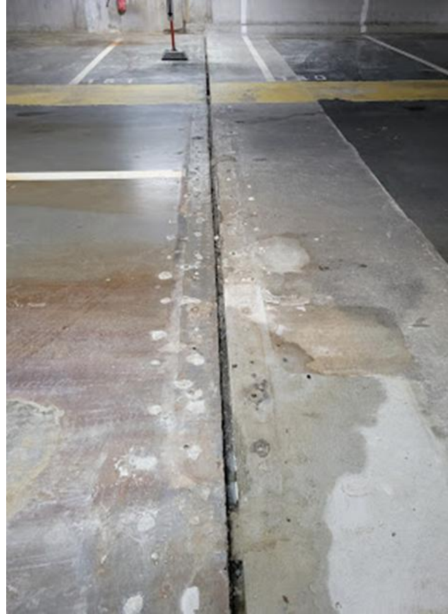
Na injectiewerken met de SPETEC® harsen
