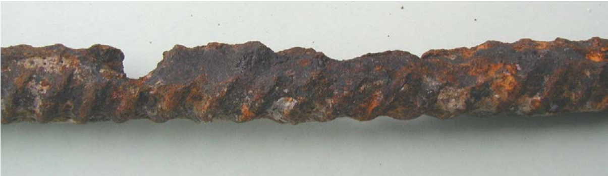
Figuur 9: Putcorrosie, veroorzaakt door chloriden
