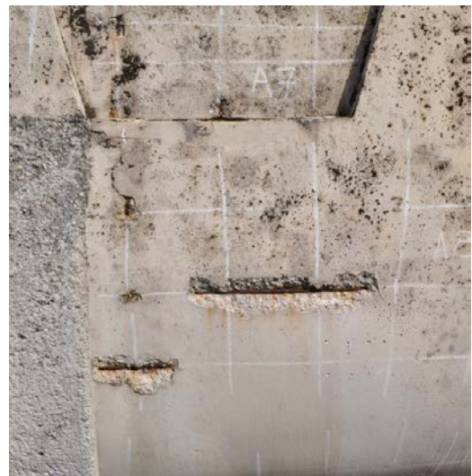
Figuur 2: Bepaling van de locatie van de wapening met een pachometer
