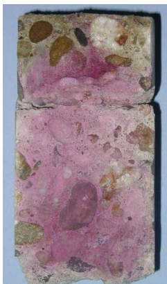
Figuur 3: Bepaling van de carbonatatie diepte op een boorkern
