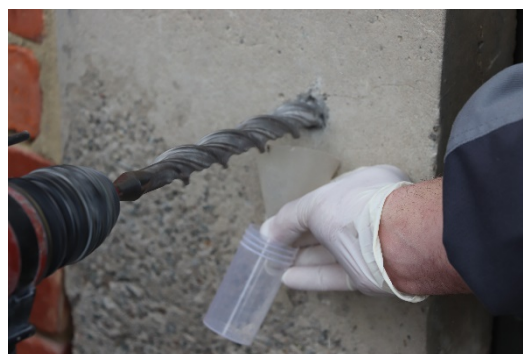
Figuur 4: Het ontnemen van boorstof voor de bepaling van het chloridegehalte
