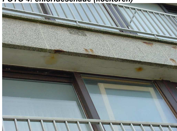
FOTO 6: chlorideschade (kustklimaat-prefabpanelen)
