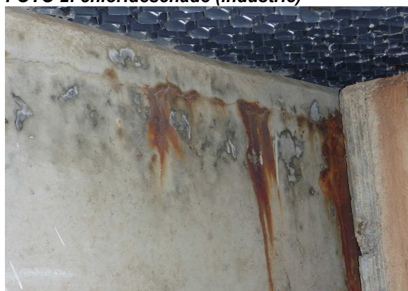
FOTO 4: chlorideschade (koeltoren)
