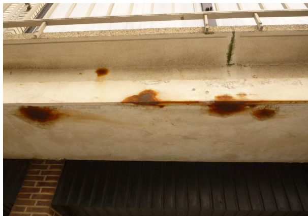
FOTO 1: chlorideschade (kustklimaat)
