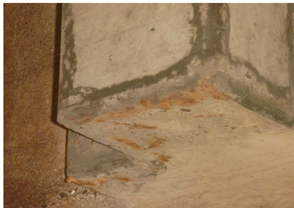
FOTO 10: geen chlorideschade (binddraadjes)
